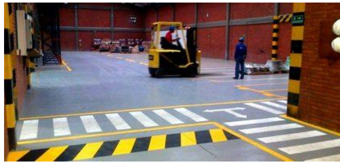
Figura 21. Marcas Viales en el Interior de la Nave
